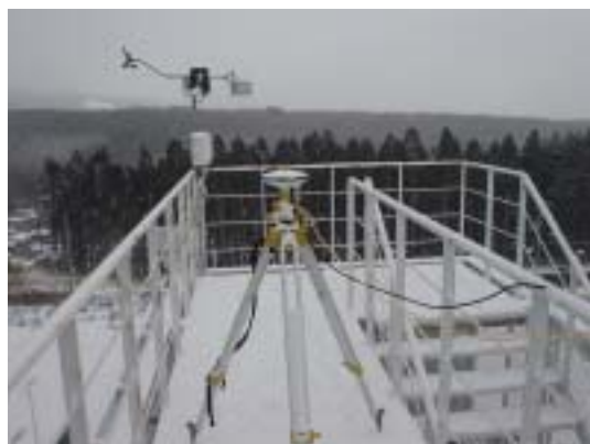
屋外GPSアンテナ
